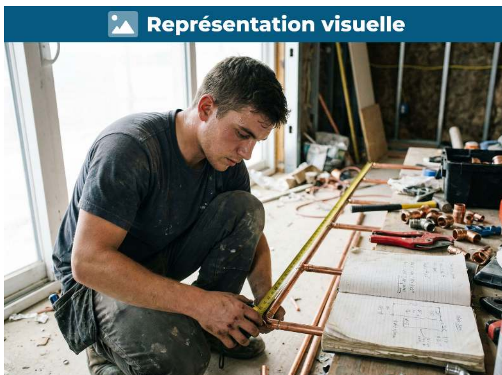
Mesurer la longueur de tuyauterie pour garantir une installation conforme aux plans
